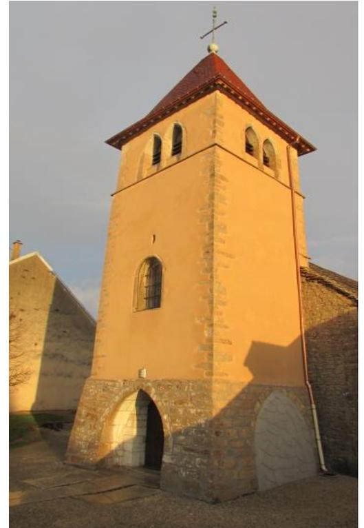
La toiture du clocher a été remise à neuf. Les travaux étaient plus conséquents car les poutres elles-mêmes étaient en mauvais état. L'entreprise « Manubonin » a dû changer certaines pièces de la charpente et tailler les chevrons dans du bois de chêne. Les petites tuiles très abimées ont été intégralement remplacées par des modèles similaires de façon à garder au clocher son aspect ancien.
